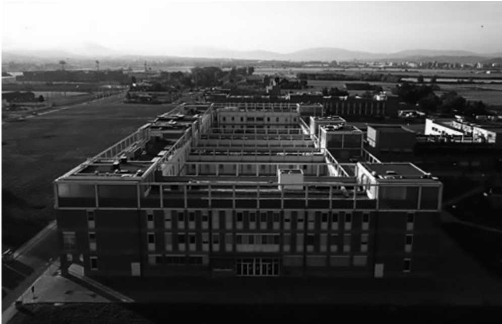
Fig. 2 – Il nuovo edificio del Dipartimento di Fisica e Astronomia al Polo Scientifico dell'Università di Firenze a Sesto Fiorentino.
