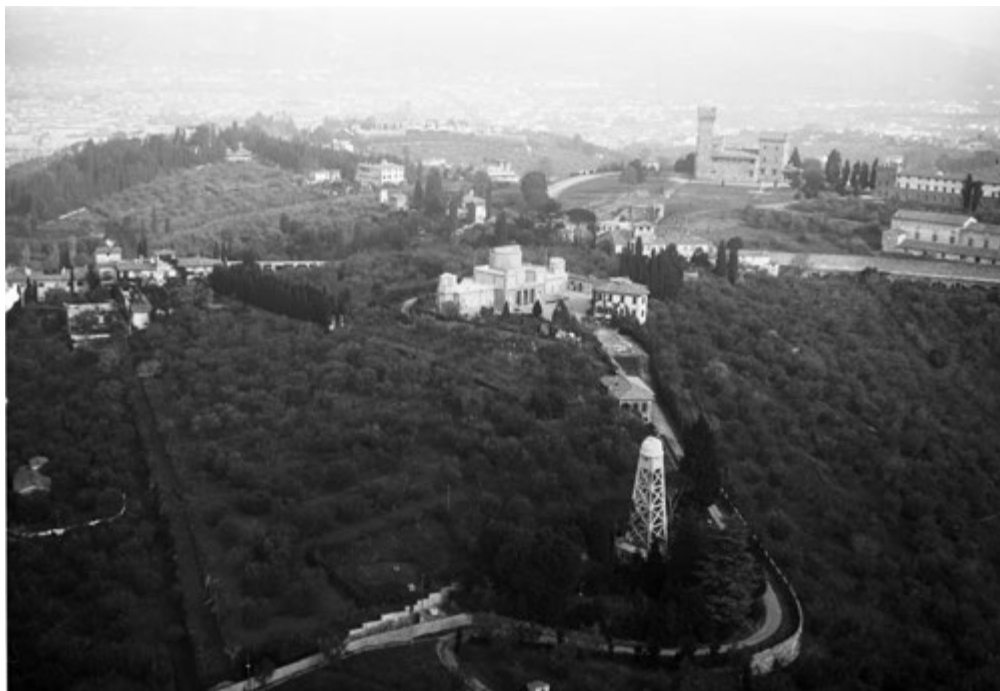
Fig. 12 – L'Osservatorio e la Torre Solare, inizio anni '30 del XX secolo. [Archivio fotografico INAF – Osservatorio Astrofisico di Arcetri]
