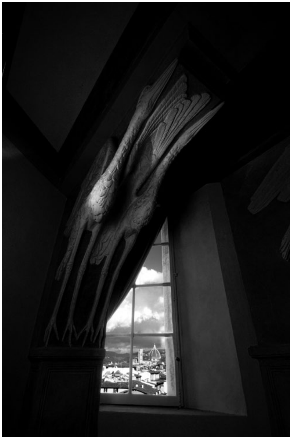
Fig. 4 – Stucchi raffiguranti cicogne nell'atto di spiccare il volo progettati dall'Architetto Giuseppe Martelli per mascherare le doppie mensole realizzate durante il restauro della copertura nel 1845-1846. [Foto Saulo Bambi]
