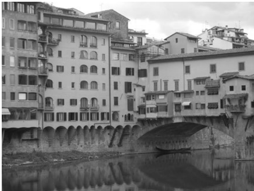
Fig. 36 Fabbricati post-bellici sul fianco sinistro del Ponte Vecchio. (Foto: P. Focarile)
