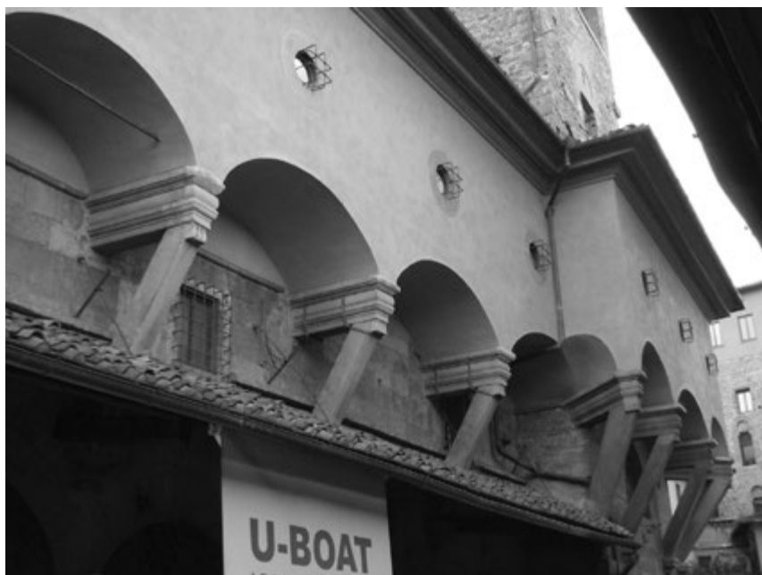
Fig. 40 Corridoio Vasariano nel tratto corrispondente alle «case» dei Mannelli, con le finestre del piano nobile fra i «beccatelli». (Foto: P. Focarile)
