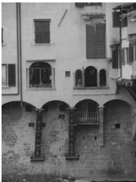
Fig. 38 Particolare della fig. 38 con due finestroni sopra gli sporti e il terrazzino sottostante. (Foto: P. Focarile)
