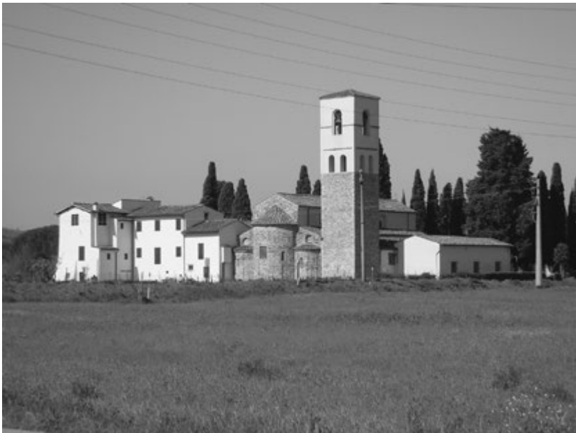
Fig. 155 Scandicci (FI), Pieve di San Giuliano a Settimo, veduta del prospetto posteriore ed edifici laterali (Foto: P. Focarile)
