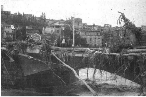
(b) Ponte alle Grazie (Photo Losacco)
