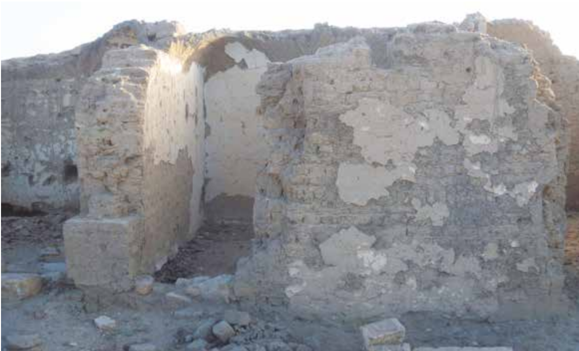
Figg. 49-64 - Stanza 2 parete nord e particolari (19 ottobre 2014)
