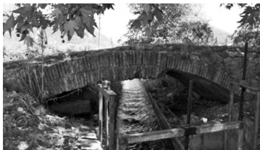
Figura 4 – Ponte di Limira: ponte romano di pietra, nell’odierna Turchia sud-occidentale; uno dei più antichi ponti ad arco ribassato del mondo.
