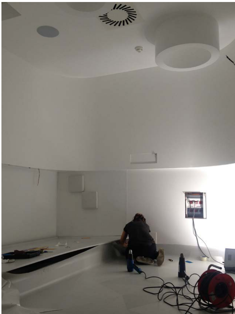
Figura 15. Il rivestimento a pavimento in pellicola vinilica.
