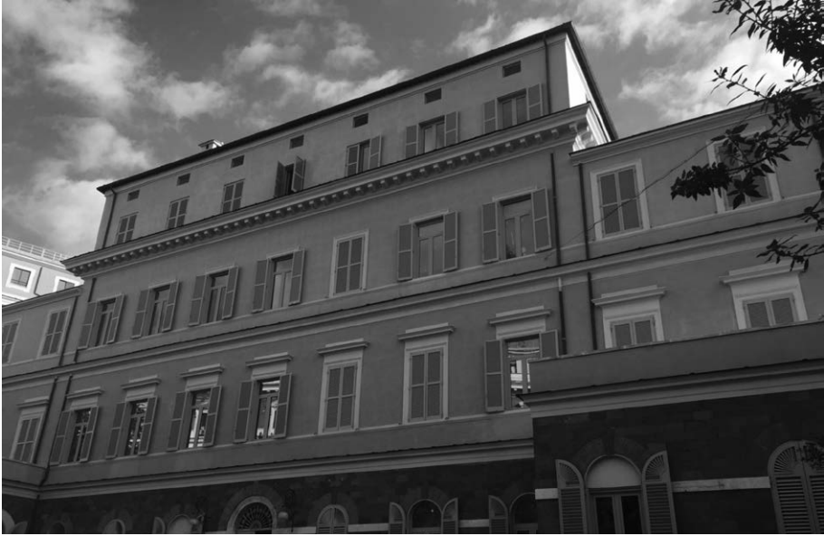
Fig. 2 – La sede del Centro Fermi, inaugurata il 28 ottobre 2019.
