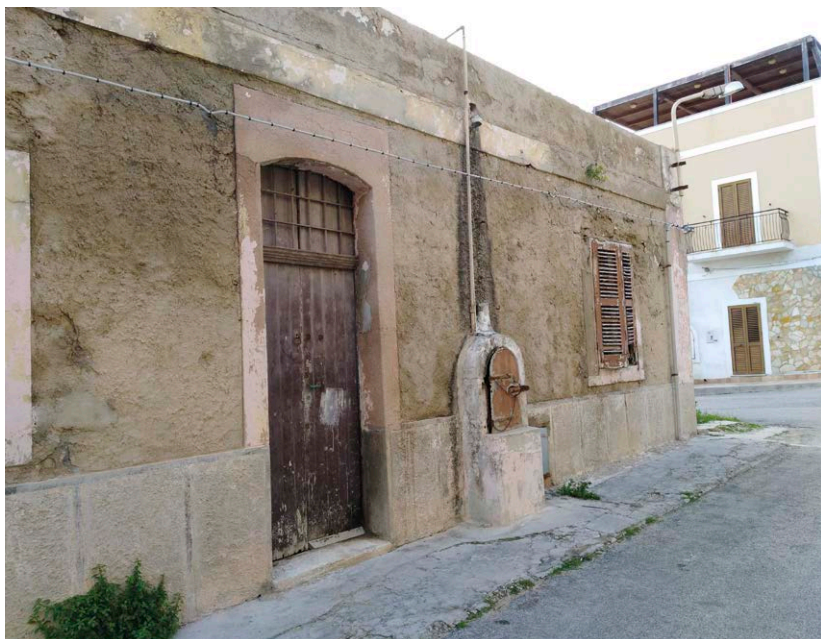
Figura 5 – Bocca di cisterna all'esterno di una abitazione. In questo caso, il tubo di raccordo con il tetto è parzialmente distrutto. [Fonte: G. Surico]
