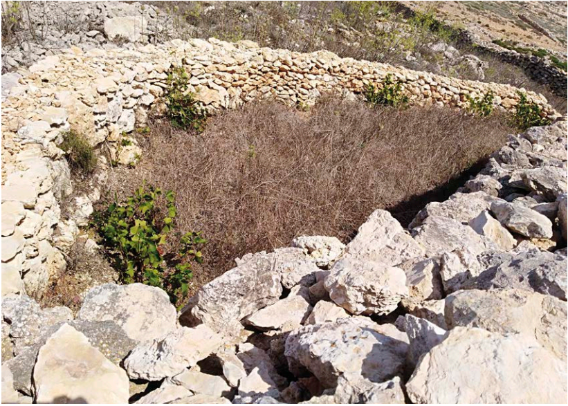
Figura 9 – Muro a secco con funzione di frangivento. Il muretto delimita uno spazio di terreno in cui residuano alcune viti cresciute a ridosso del muro. [Fonte: G. Surico, 2019]
