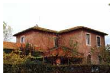
Figure 27-28. Due esempi di casali presenti lungo il fosso della Magliana.
