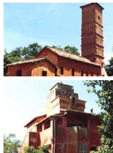
Figure 55-56. Alcuni esempi di casali entro i quali sono ancora rintracciabili i “residui” storici di costruzioni militari e religiose.
