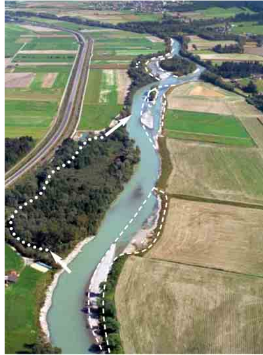
Figura 16. Progetto Drava: interventi in località Kleblack.
