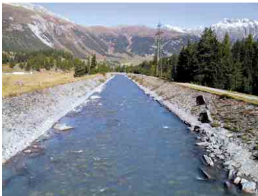
Figura 10. Il fiume Flaz prima dell’intervento.
