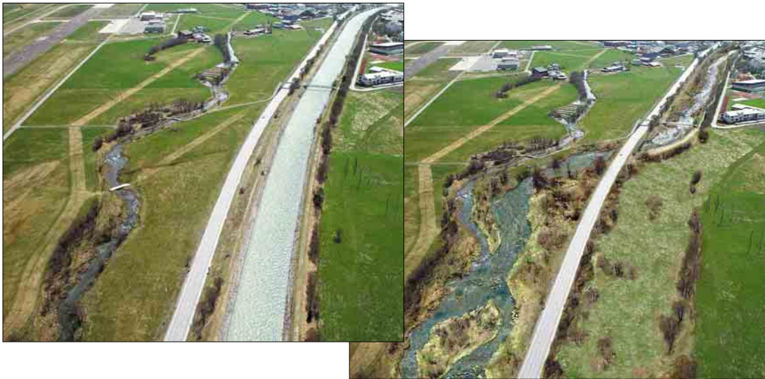
Figura 14. Sinistra - Fiume Inn: situazione attuale con interventi di riqualificazione all’interno dell’alveo (provvedimento attuato). Destra - Fiume Inn: situazione futura con progetto di un nuovo alveo (provvedimento ancora non attuato).
