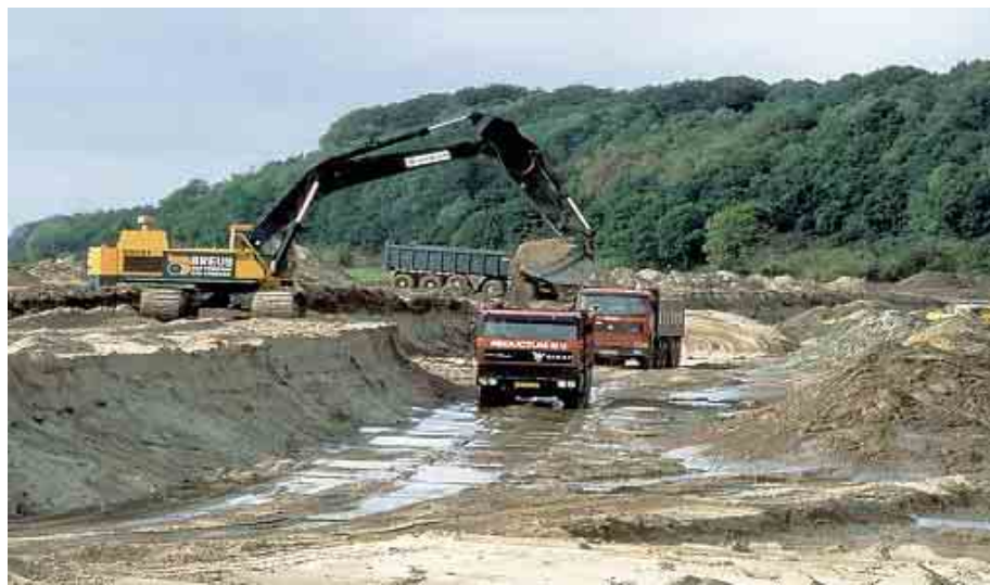
Figura 13. Intervento uno: interventi per l'abbassamento dell'area golenare.
