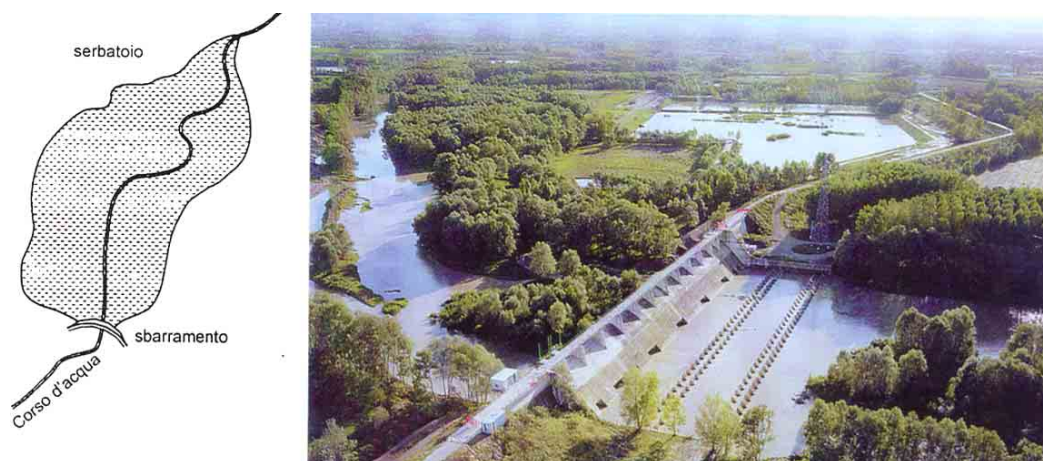
Figura 3. Cassa d'espansione in linea: schema e foto.
