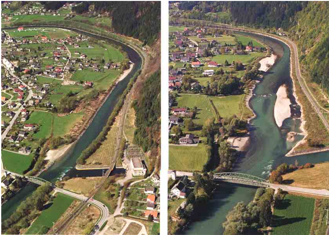
Figura 24. “Prima e dopo”: un tratto del fiume Drava prima (a sinistra) e dopo il progetto di riqualificazione (a destra).
