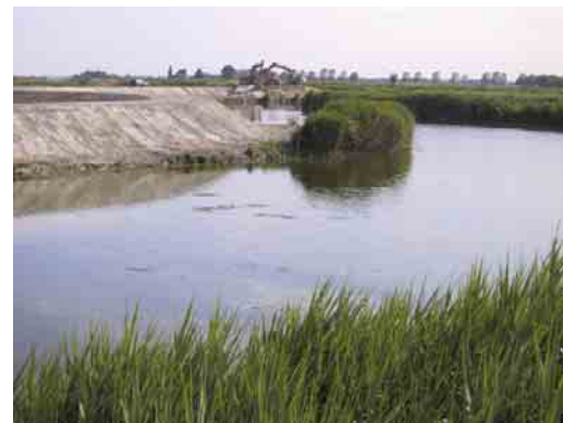
Figura 14. Lavori per il risezionamento e la risagomatura degli argini esistenti.
