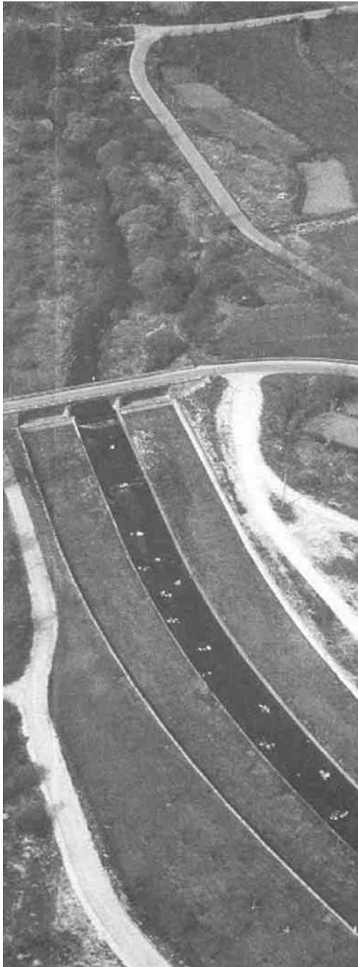
Figura 3. Fiume Sangro: inizio del tratto canalizzato.
