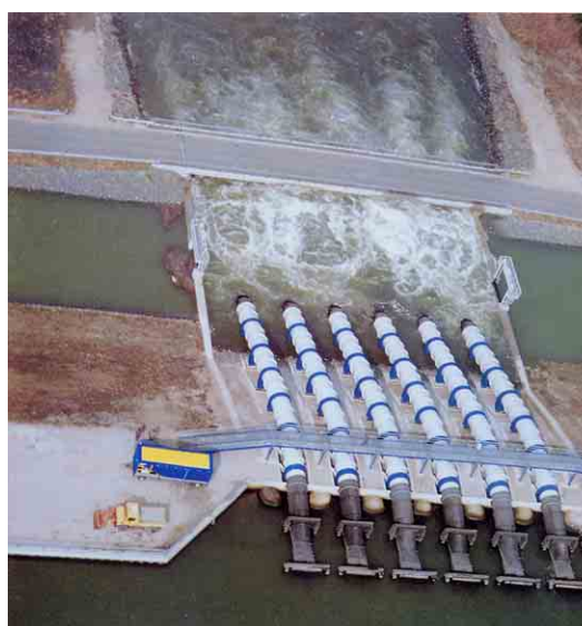
Figura 9 (sopra). Sfiatore laterale. Figura 10 (sotto). Batterie di sifoni.
