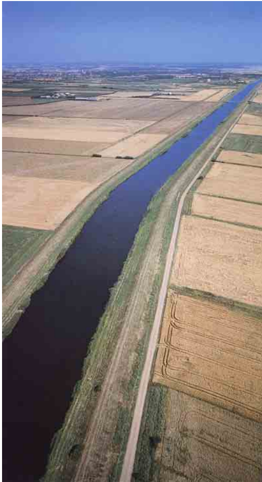
Figura 19. Il risultato finale: il fiume trasformato in un canale.
