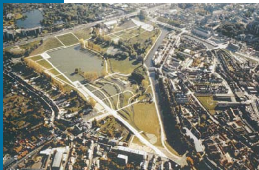
Figura 10 Il nuovo Parc Saint Pierre 'incuneato' tra il quartiere della Cattedrale a sud, il quartiere Saint-Leu a ovest, l'ampia distesa degli hortillonnages a est e i nuovi quartieri periferici a nord.
