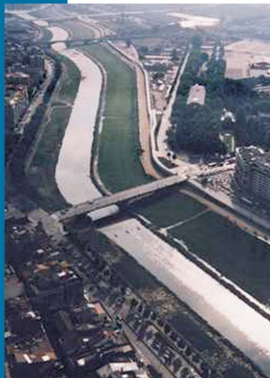
Figura 16 La realizzazione dell'intervento ha permesso di restituire alla città gli spazi di relazione con il fiume attraverso la creazione di un esteso parco urbano.
