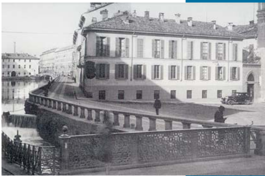
Figura 96 Il ponte, la conca e il parapetto in granito sul Naviglio Martesana, 1930 circa, archivio privato.
