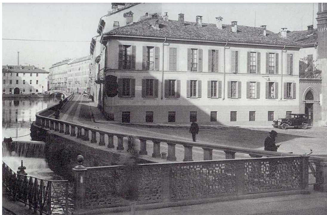
Figura 73 Il ponte sul Martesana in via San Marco e il parapetto lungo l'alzaia, Archivio privato.
