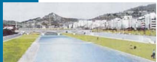
Figura 18 Uno schizzo di progetto mette in evidenza l'opportunità offerta dall'intervento di riqualificare i margini del solco fluviale per renderli fruibili da parte dei cittadini.
