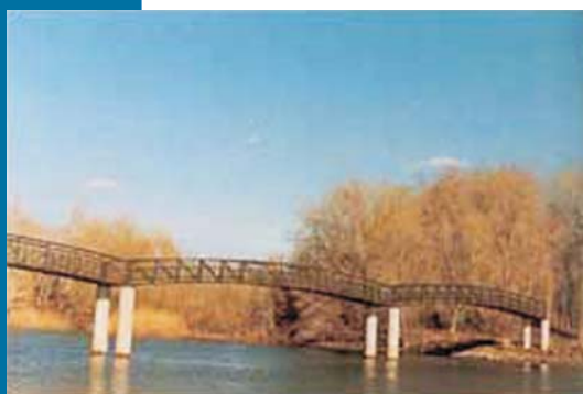
Figura 31 Il ponte pedonale che attraversa il Segre all'interno dell'area umida denominata "La Mitjana".
