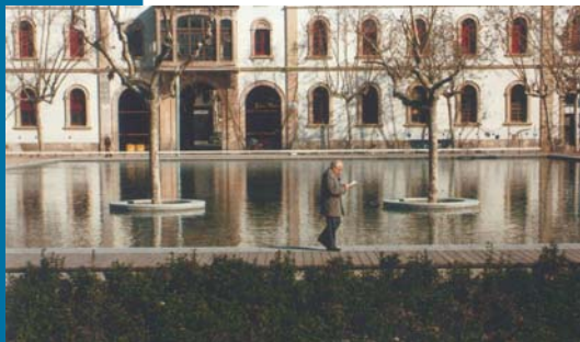
Figura 3 La grande lamina d'acqua che contraddistingue il giardino nel quale trova riflesso il fronte edificato.
