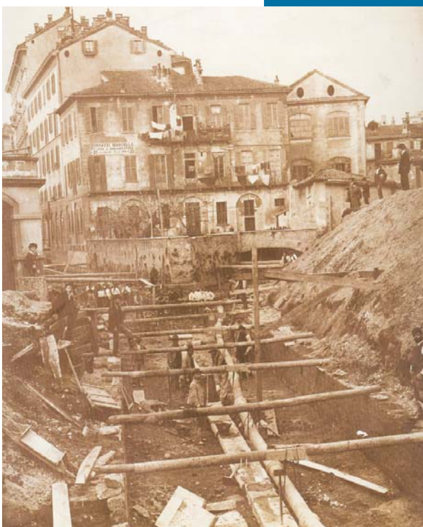
Figura 122 Rifacimento della copertura del cavo Redefossi in via Monte Santo, Milano, Archivio Storico F.C.A.
