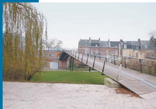
Figura 28 La struttura della passerella pedonale realizzata in metallo collega il parco con il quartiere Saint-Leu e da questo al centro cittadino e alla Cattedrale.
