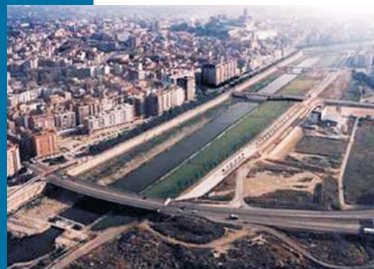
Figura 14 Lo stesso tratto del fiume dopo l'intervento di canalizzazione e creazione dei prati laterali.
