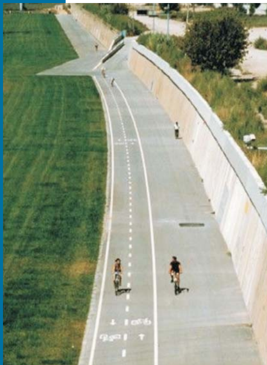
Figura 32 La nuova accessibilità al fiume e i percorsi ricavati ai margini del muro di contenimento garantiscono il recupero delle relazioni tra il tessuto urbano e il corso d'acqua.
