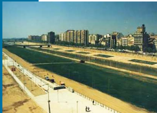
Figura 17 I lavori di sistemazione delle sponde lungo il corso del fiume Segre.
