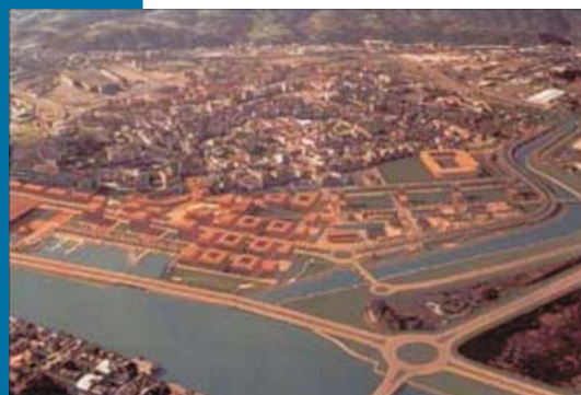
Figura 8 Il progetto dell'area "Galindo" gestito dalla società "Bilbao ría 2000" nell'ambito comunale di Barakaldo.
