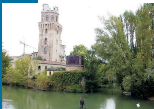
Figura 27 La Torre maggiore del vecchio Castello ("Specola") affacciata sul Tronco Maestro.
