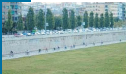
Figura 31 Gli alti muri di contenimento definiscono i limiti dell'invaso fluviale e delimitano gli estesi percorsi pedonali e ciclabili.
