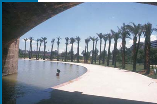
Figura 26 La suggestiva presenza dell'acqua attorno alla struttura del ponte è definita dalla palme che seguono il bacino circolare.
