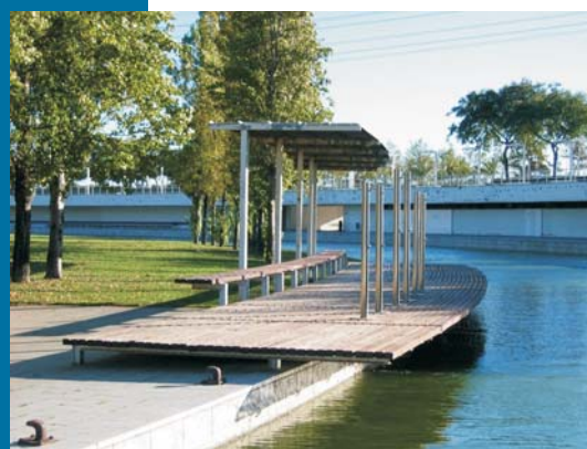
Figura 17 Il canale d'acqua e la piattaforma in legno che si inserisce a sbalzo sull'acqua.
