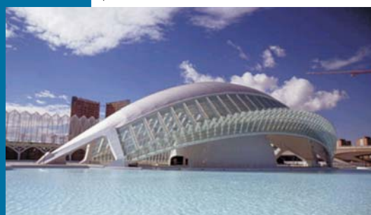
Figura 24 L'architettura dell'Hemisfèric progettata da Santiago Calatrava.
