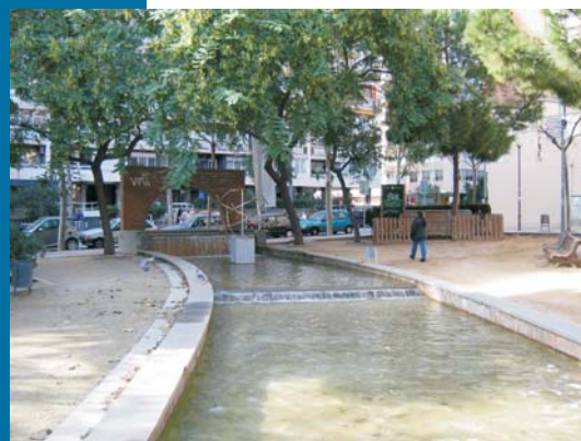
Figura 8 Le arcate in mattoni segnano le estremità del canale e richiamano le antiche attività industriali del quartiere.
