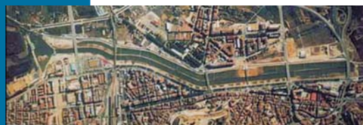
Figura 11 Foto aerea del tratto di fiume interessato dall'intervento dopo il 1997.
