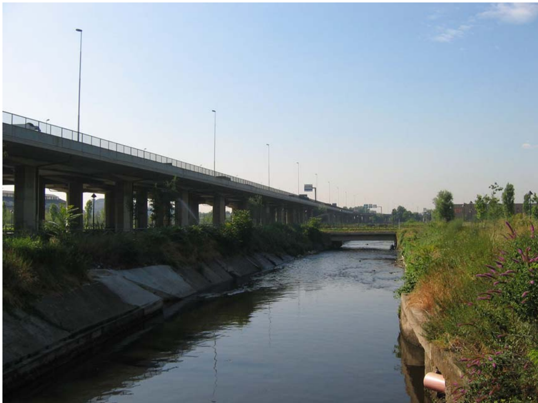
Figura 8 Il fiume viene progressivamente canalizzato e le sponde sempre più minacciate dalle infrastrutture urbane perdono progressivamente la naturalità e la morfologia originaria.
