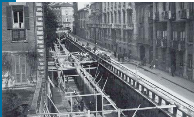
Figura 120 Lavori di copertura del naviglio interno in via Senato, 1929-1930, Milano, Archivio Storico F.C.A.
