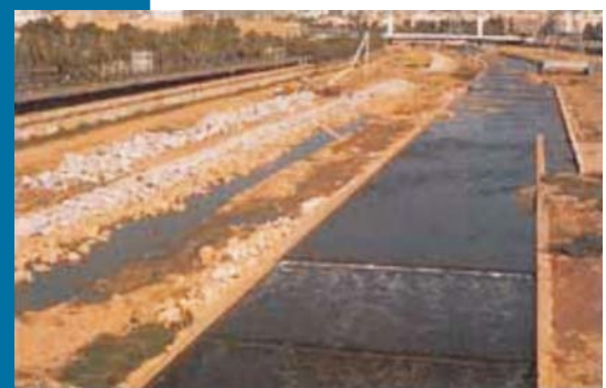
Figura 8 L'ampliamento della sezione occupata dalle acque del fiume ha permesso di ridurre l'inondabilità delle nuove aree verdi fruibili.
