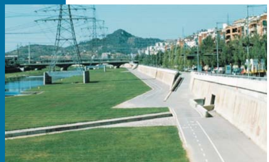
Figura 30 Le rampe di accesso all'area verde fruibile ricavate all'interno dei muri di contenimento esistenti.
