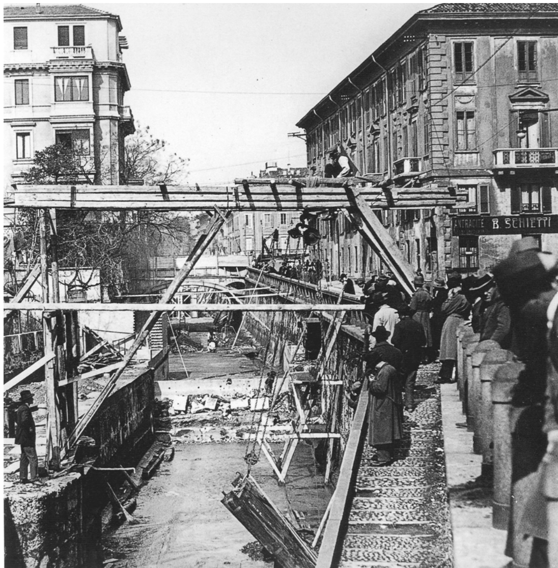
Figura 77 Lavori di copertura della cerchia dei navigli in via Senato e in via San Damiano, 1929, Milano, Civico Archivio Fotografico del Castello Sforzesco.
