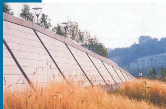
Figura 11 I nuovi argini che delimitano le sponde fruibili del Rhône.
