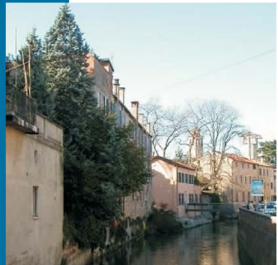
Figura 7 I canali interni al centro cittadino.
