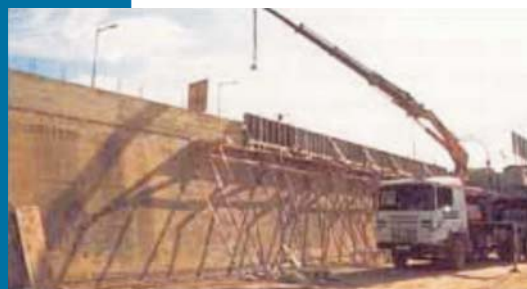
Figura 12 L'innalzamento del muro di contenimento per aumentare la capacità idraulica della sezione fluviale in caso di piena.
