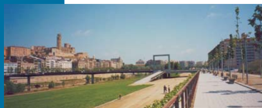
Figura 21 Le sponde sono state relazionate allo spazio urbano attraverso percorsi e discese al fiume.
