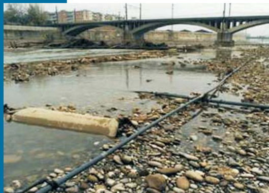
Figura 7 Il degrado e l'abbandono del fiume e dei margini fluviali prima dell'intervento.
