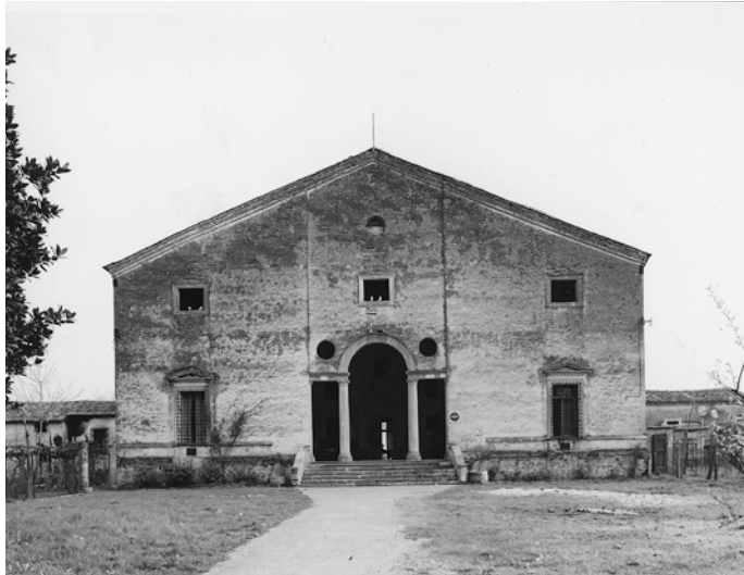
(in alto) Andrea Palladio, Villa Valmarana Bressan , Monticello Conte Otto (VI) 1542-1560, ridisegno della pianta del piano terra sulla base del disegno RIBA XVII 2R. (in basso) Andrea Palladio, Villa Valmarana Bressan , Monticello Conte Otto (VI) 1542-1560, foto 1971, © CISA A. Palladio.
