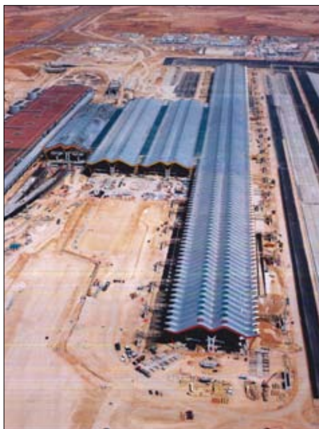
Fig. 18 Aeroporto Barajas, Madrid: vista aerea del nuovo terminal e delle strutture di parcheggio ( The Photographer - MAC Fotografica).
