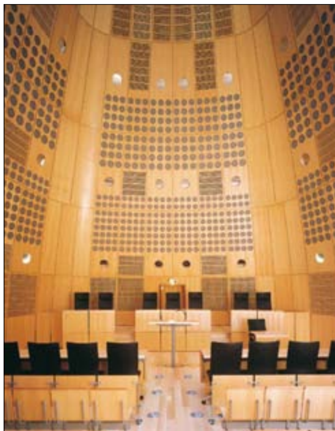
Fig. 12 Palazzo di Giustizia di Bordeaux: la superficie in legno delle pareti interne serve a dare una buona acustica alle aule per le udienze ( The Photographer - Christian Richters).
