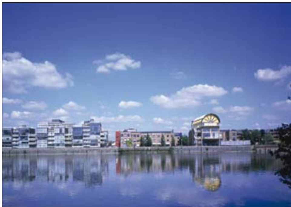
Fig. 2 Thames Wharf Studios, Londra: i magazzini, costruiti all'inizio del XX secolo lungo il Tamigi, ospitano oggi la sede dello studio Rogers ( The Photographer - Katsuhisa Kida).
