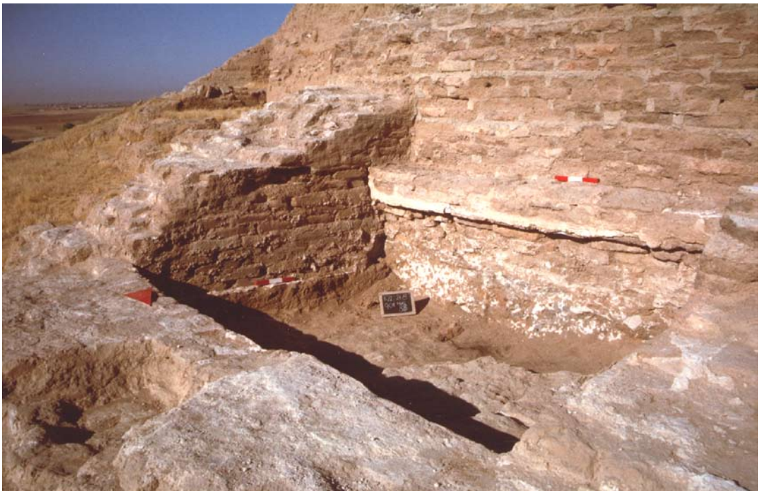
b. Grande Muro di Difesa. Il vano 88. Veduta generale a fine scavo. Nel muro di fondo del vano, 1, si distingue, dal basso, la base di malta su cui poggiano le fondazioni, la risega, e poi l'alzato. Da ENE.
