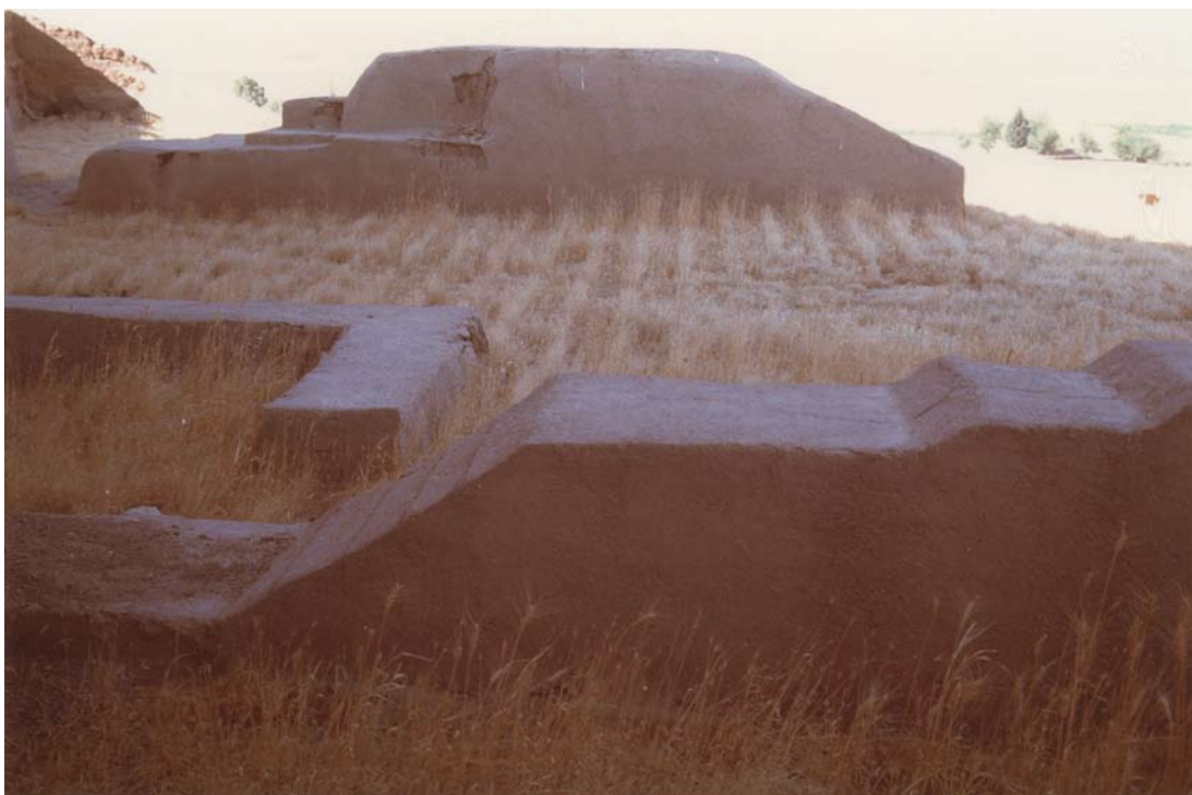
b. Le strutture del palazzo di Tukulti-Ninurta II dopo un anno dal restauro. Da N.
