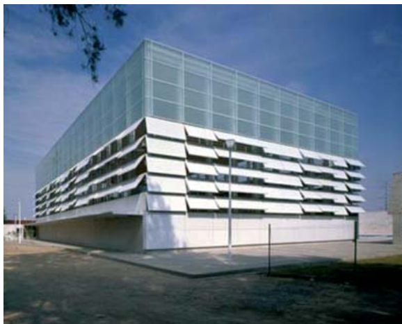
Figura 1 – New Gymnasium a Gadalaiaira di Ten Arquitectos , 2000 (fonte: TEN, “ TEN Arquitectos: Enrique Norten, Bernardo Gomez-Pimentá ”, Revised ed, New York, 2002).
