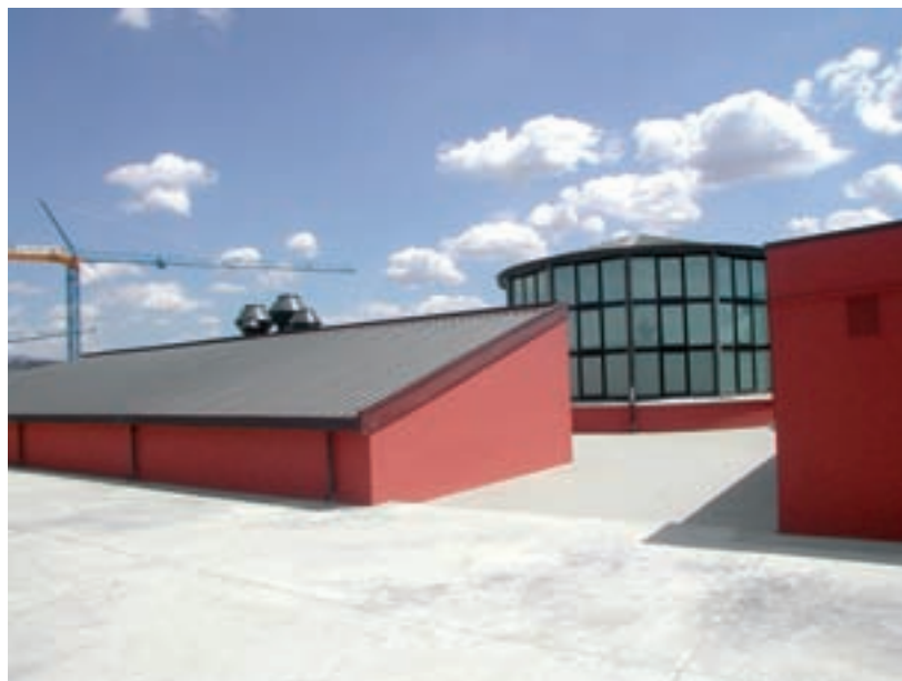
Veduta esterna: il tetto.
