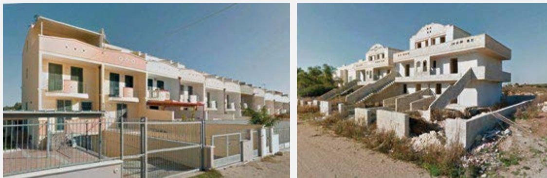
Figura 1. Google StreetView. Zone C realizzate in località Torre San Giovanni.
