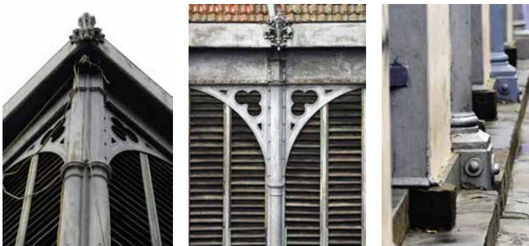
Fig. 135-136-137 Mercato succursale di Sant' Ambrogio, dettagli della struttura metallica col giglio fiorentino e dei montanti cavi in ferro (Gianluca Dellanoce, 2018).
