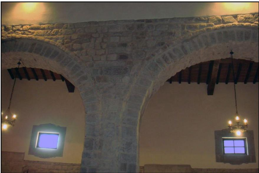
I pilastri risultano essere cruciformi, data la presenza di paraste sui lati est e ovest, e le murature soprastanti sono a filo con le paraste, quindi rilevate rispetto alle arcate. I pilastri sono realizzati in conci di arenaria di piccole e medie dimensioni regolarizzati nella faccia a vista con uno strumento a punta, disposti alternativamente (ma senza uno schema regolare) di testa e di taglio e legati da abbondante malta.
