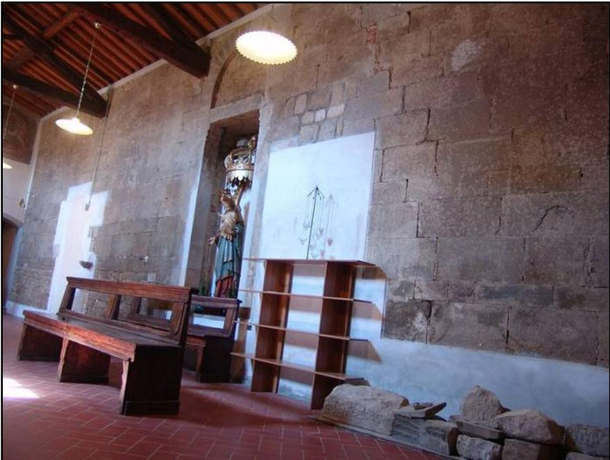
All'interno è inoltre visibile un ampio paramento murario in arenaria pertinente con l'originale fianco sinistro della struttura medievale, oggi inglobato nei locali della canonica, e porzioni più limitate pertinenti con il fianco destro, oggi visibili nell'appartamento del parroco.
