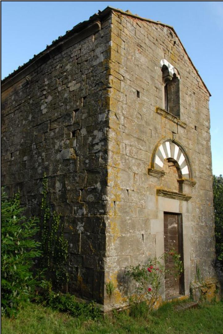
A seguito di questo crollo, venne ricostruita la parete laterale destra, il transetto destro e la parte superiore della testata della navata. L'ultimo grande intervento ricostruttivo si ha nel ventesimo secolo, quando viene costruita una nuova copertura per la chiesa, realizzata con capriate lignee e non voltata come era prima.
