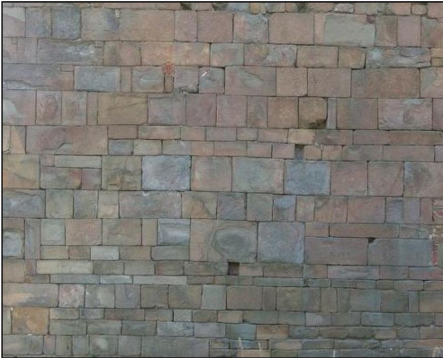
I corsi più bassi servono anche a cercare di recuperare un'orizzontalità di imposta che si stenta a mantenere: soprattutto nel fianco, complice anche il
