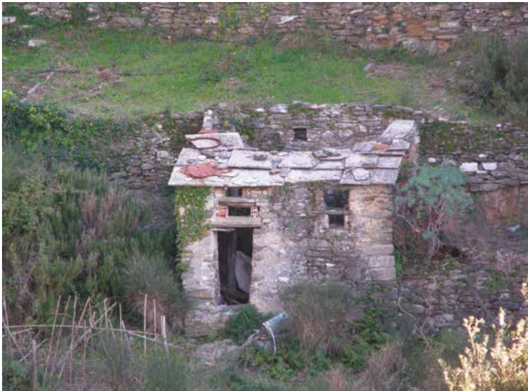
↑ Fig. 2 Un petit bâtiment rural abandonné dans le paysage en terrasses des Cinqueterre (SP): on peut voir une niche créée dans le mur amont, qui faisait partie du mobilier intérieur du bâtiment, @ A. Ghersi.
