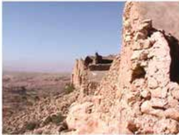
Vue du Ksar El Jouamâ dans la région montagneuse de Béni-Khédache qui domine les terrains agricoles. Source Photos :K. Laroussi, s.d.
