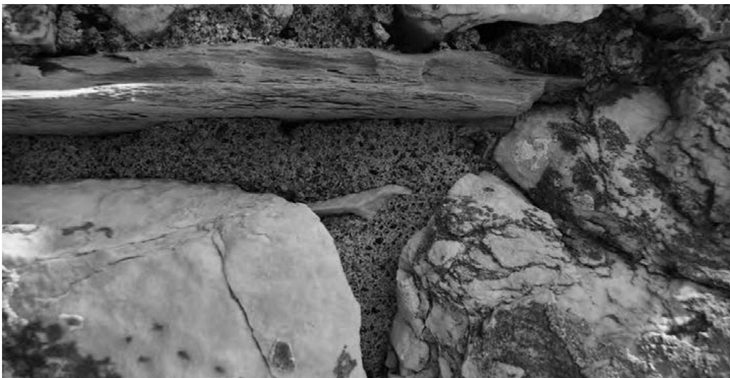
Figura 3 Dettaglio dei degradi di una muratura
