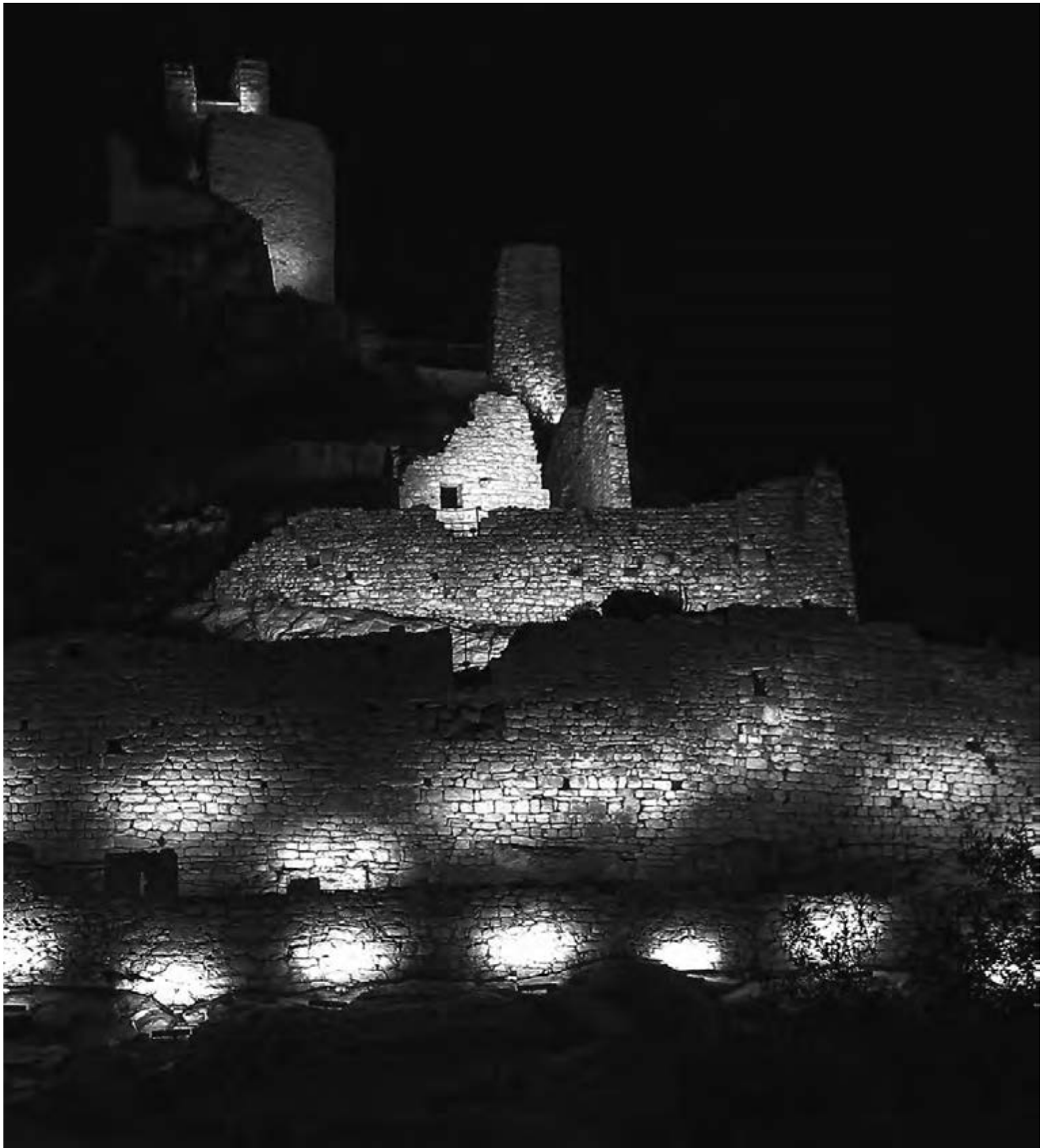
Figura 9 Rocca San Silvestro, Foto dopo i lavori di messa in opera del sistema di illuminazione
