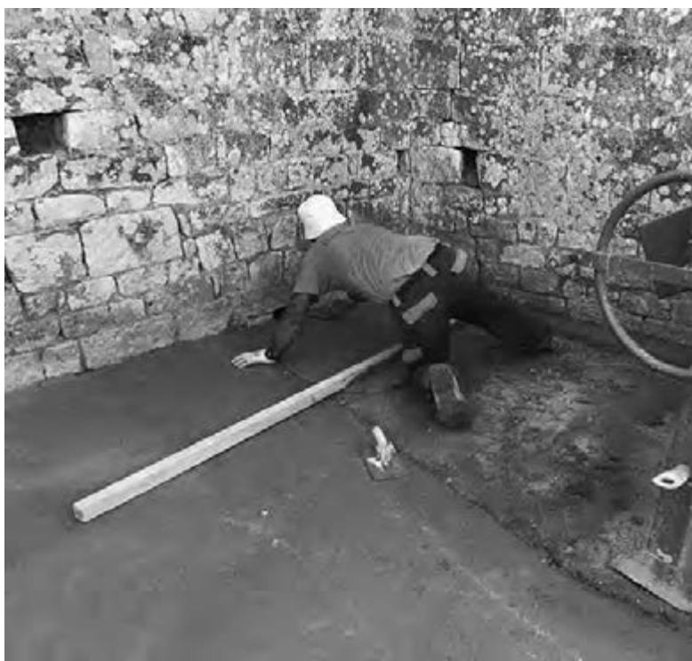
Figura 3-4 UT 2, area signorile, restauro della pavimentazione
