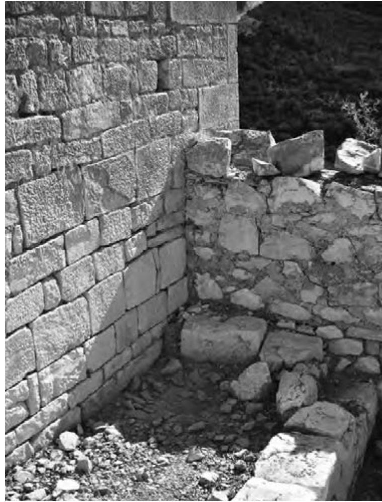
Figura 2 UT 4, chiesa, ammorsamento tra due paramenti differenti sotto il punto di vista costruttivo
