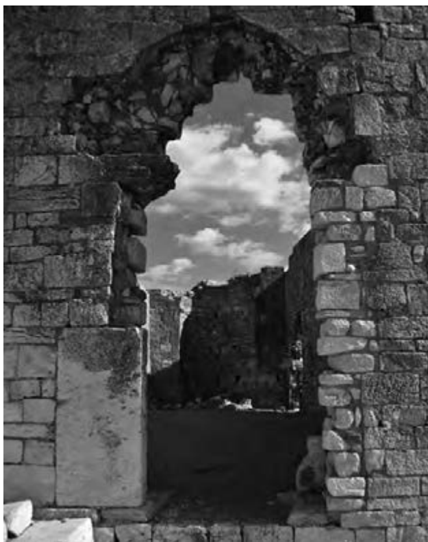
Figura 5 Ut 4, chiesa, foto della porta di accesso prima dei lavori di restauro
