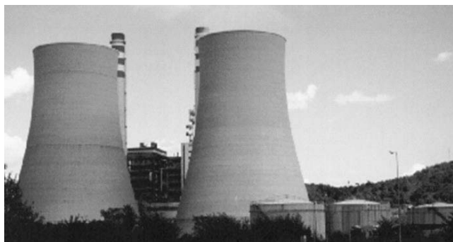
Fig. 35 Foto delle torri di raffreddamento della centrale ENEL di Santa Barbara
