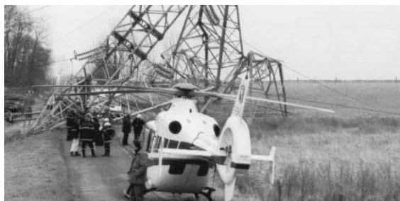
Fig. 24 Foto di un traliccio collassato dopo il passaggio di una bufera in Francia nel 1999
