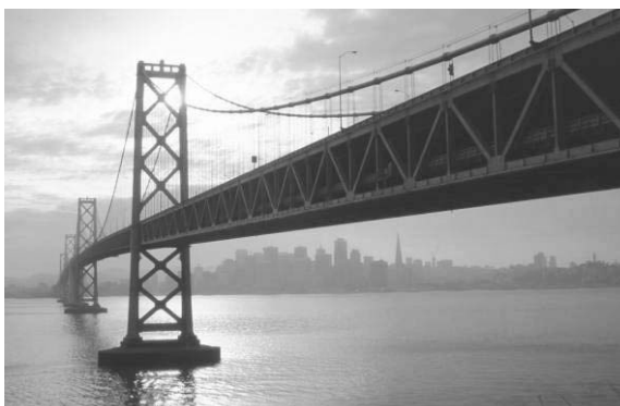
Fig. 12 Foto del San Francisco-Oakland Bay Bridge
