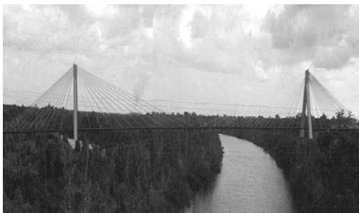
Fig. 38 Foto del ponte sul Rio Higuamo, Repubblica Domenicana
