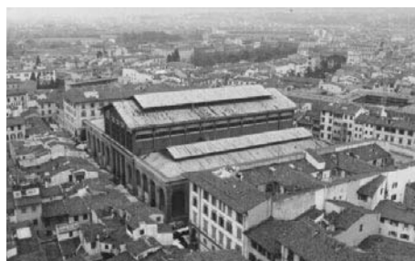
Fig. 26 Foto della copertura del mercato centrale di San Lorenzo
