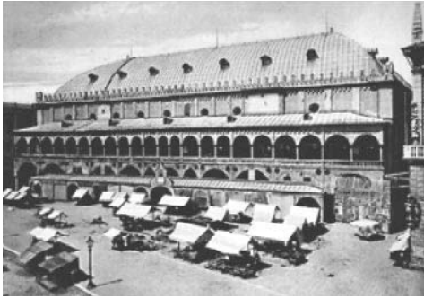
Fig. 30 Foto del Palazzo della Ragione in Padova
