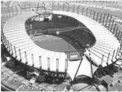
Fig. 41 Foto stadio Delle Alpi di Torino
