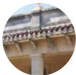
A48 Vivienda Martínez Guanabo Estado general II Calidad arquitectónica III S11
