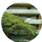
A26 Módulo Escolar Tarará | Megano Estado general II Calidad arquitectónica III S07 I39Hh I40Hh I41Hh
